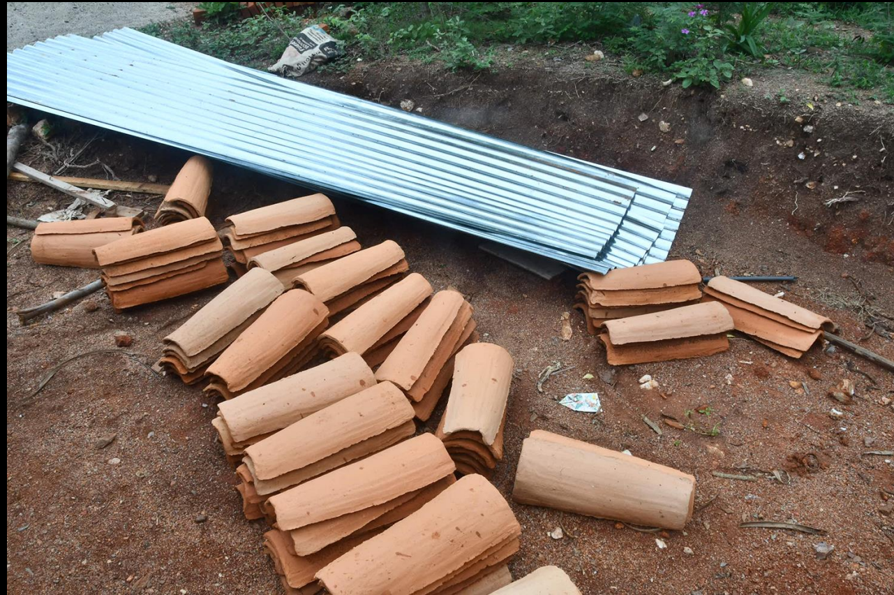
Techo: perlines, zinc y teja
